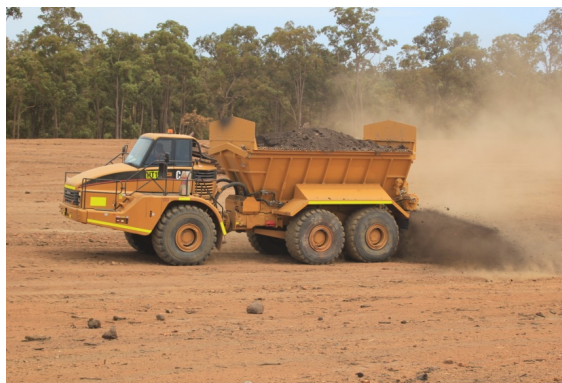
Gambar 7.20 Penyebaran lapisan tanah atas baru di tambang Alcoa, Australia Barat
