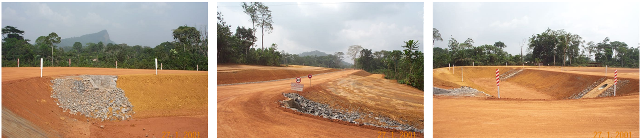
Gambar 7.23 Kombinasi pengendalian erosi sementara dan permanen di Alufer Bel Air, Guinea
